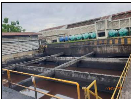
รูปที่ 2-16 บ่อพักน้ำหล่อเย็น
