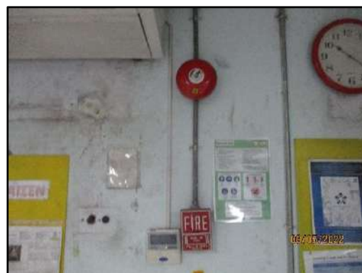
รูปที่ 2-26 อุปกรณ์เตือนภัยกรณีเกิดเหตุเพลิงไหม้
