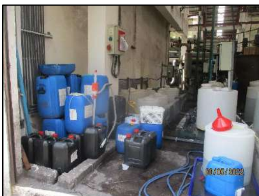
รูปที่ 2-40 Bund Wall รอบถังสารเคมี
