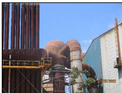
รูปที่ 2-5 ระบบดักจับและกรองฝุ่นแบบ Canopy Hood
