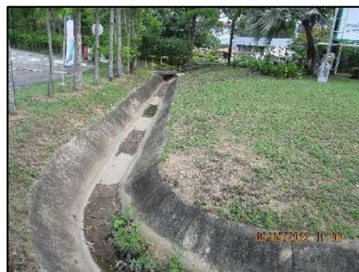
รูปที่ 2-34 รางระบายน้ำคอนกรีต
