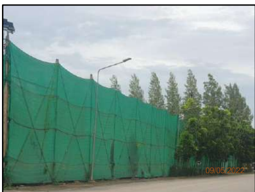
รูปที่ 2-8 แนวสแลนเพื่อลดการฟุ้งกระจายของฝุ่นละออง
