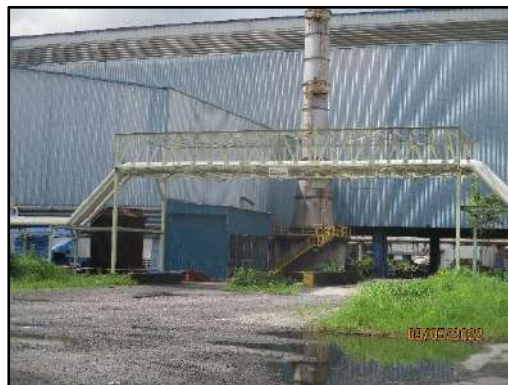
รูปที่ 2-15 ระบบปรับปรุงคุณภาพน้ำสำหรับการใช้ประโยชน์ภายในโครงการและทอส่งน้ำ เข้าสู่ระบบหล่อเย็นเครื่องจักรของโรงรีดและโรงหลอม
