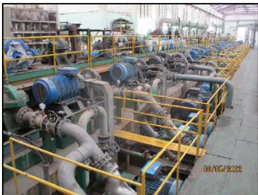
รูปที่ 2-15 ระบบปรับปรุงคุณภาพน้ำสำหรับการใช้ประโยชน์ภายในโครงการและทอส่งน้ำ เข้าสู่ระบบหล่อเย็นเครื่องจักรของโรงรีดและโรงหลอม
