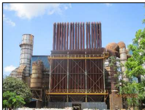
รูปที่ 2-3 ระบบดักฝุ่นแบบถุงกรอง (Bag House)
