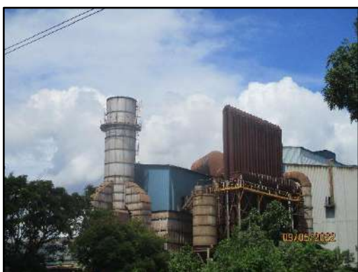
รูปที่ 2-4 ระบบดักจับและกรองฝุ่นแบบ Fume Plant
